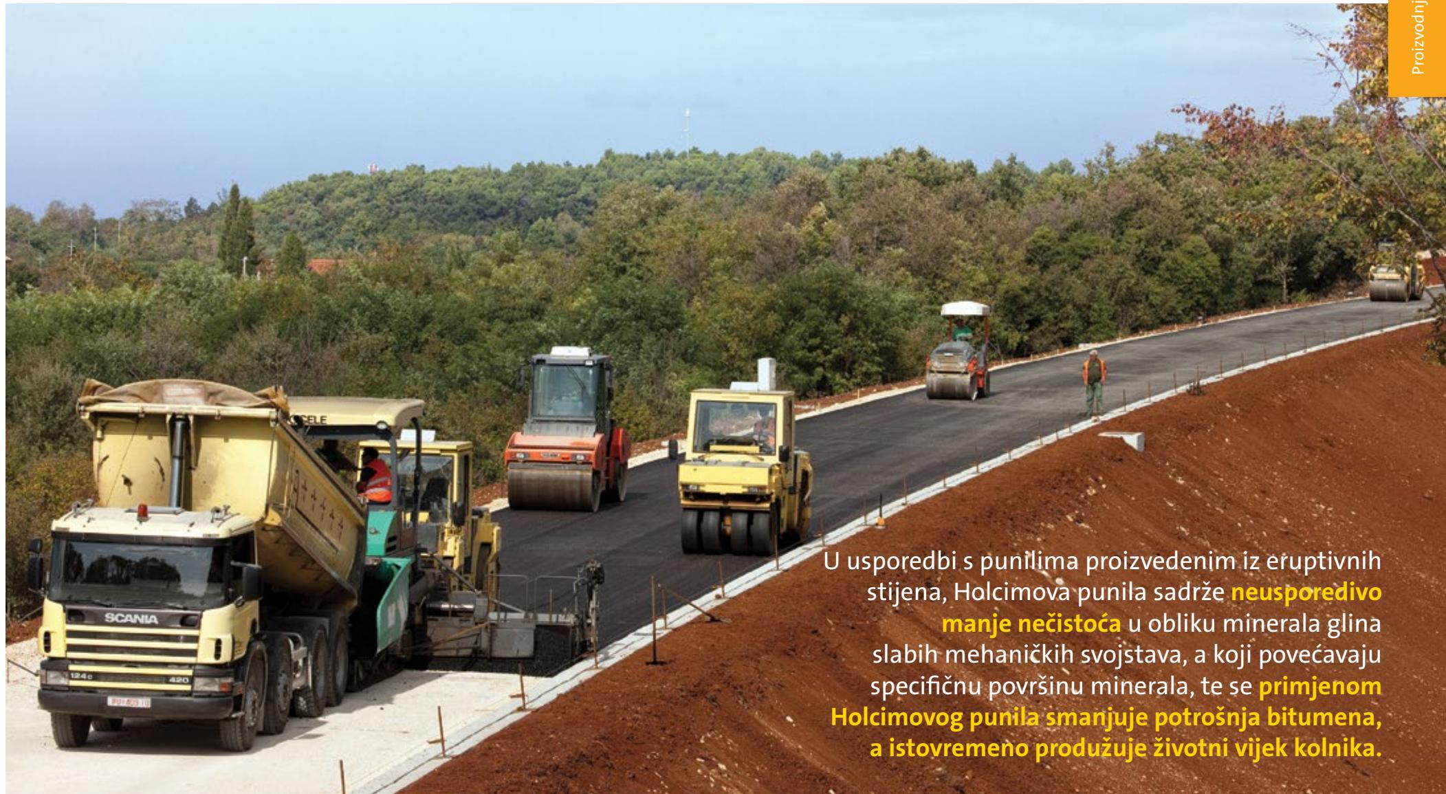
U usporedbi s punilima proizvedenim iz eruptivnih stijena, Holcimova punila sadrže **neusporedivo manje nečistoća** u obliku minerala glina slabih mehaničkih svojstava, a koji povećavaju specifičnu površinu minerala, te se **primjenom Holcimovog punila smanjuje potrošnja bitumena, a istovremeno produžuje životni vijek kolnika.**
