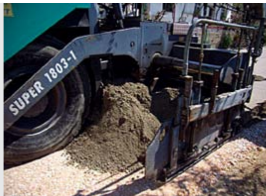
Slike 1/3 i 1/4: Ugradnja uvaljanog betona uporabom finišera (za asfalt)
