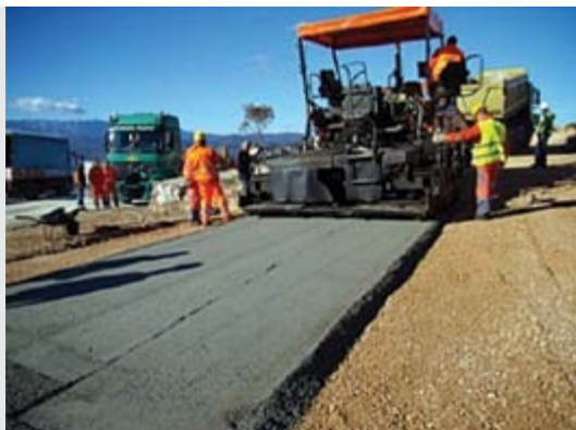
Slike 1/3 i 1/4: Ugradnja uvaljanog betona uporabom finišera (za asfalt)
