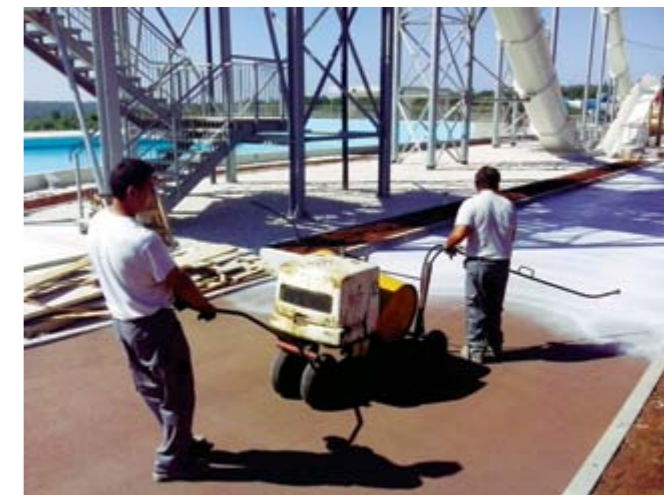
Slika 5/1: Njegovanje ugrađenog uvaljanog betona
