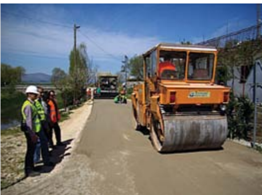
Slike 1/5 i 1/6: Zbijanje uvaljanog betona uporabom valjaka
