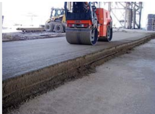
Slike 1/5 i 1/6: Zbijanje uvaljanog betona uporabom valjaka
