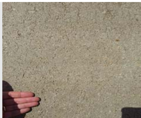
Slike 1/9 i 1/10: Tekstura i izgled gornje površine kolnika od uvaljanog betona
