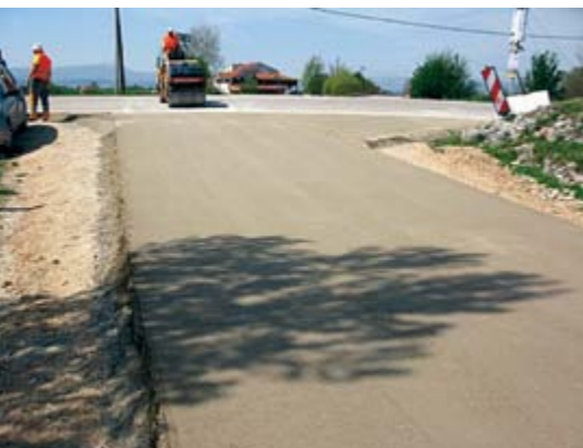
Slike 1/9 i 1/10: Tekstura i izgled gornje površine kolnika od uvaljanog betona
