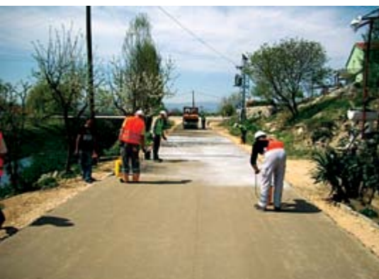
Slike 1/7 i 1/8: Njega ugrađenog betona uporabom odgovarajućih kemijskih sredstava
