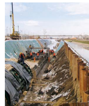
Gradnja Južnog dovodnog kanala
