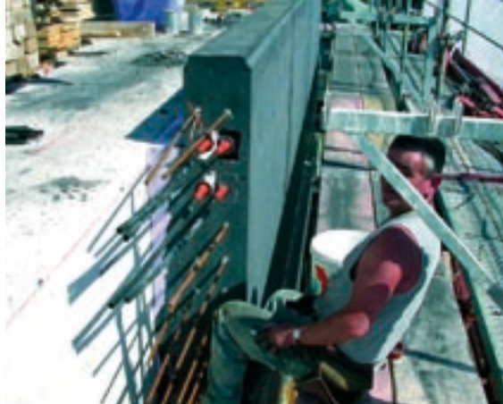
Autorska prava: Alfons Ottiger, Zug Element tamne betonske fasade gdje se dobro vidi armiranje i pred-napinjanje.
