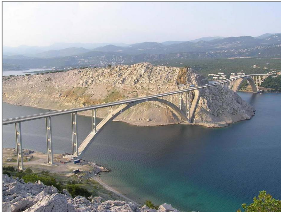
MOST KRK – najveći raspon armiranobetonskog luka (1980)
