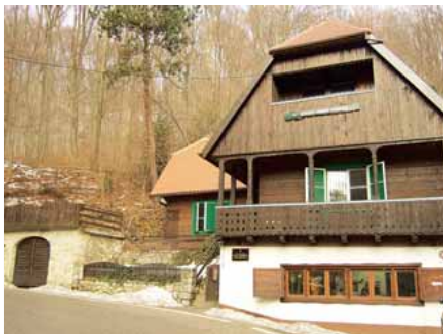
Zgrada Uprave Parka prirode Medvednica
