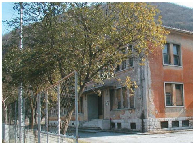
Zgrada Majstila postat će Poduzetnički inkubator
